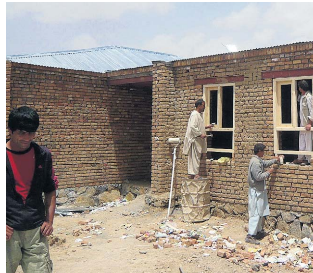
Während die Fensterrahmen der neuen Schulzimmer eingesetzt werden, wird drinnen bereits unterrichtet.
