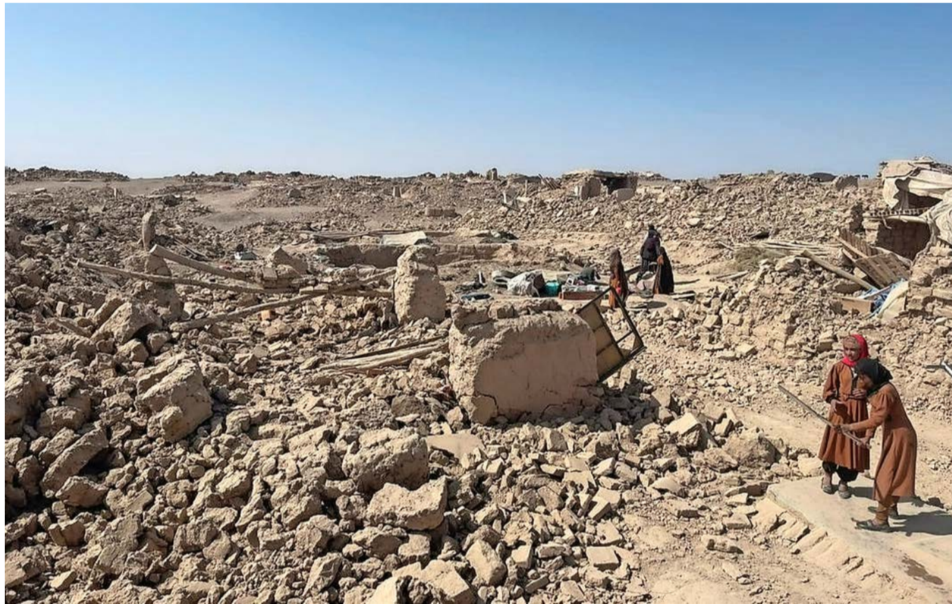
Diese Aufnahme erhielt Michael Kunz am Mittwoch von einem Projektpartner vor Ort. Eine Woche zuvor standen hier noch Gebäude. BILD ZVG
